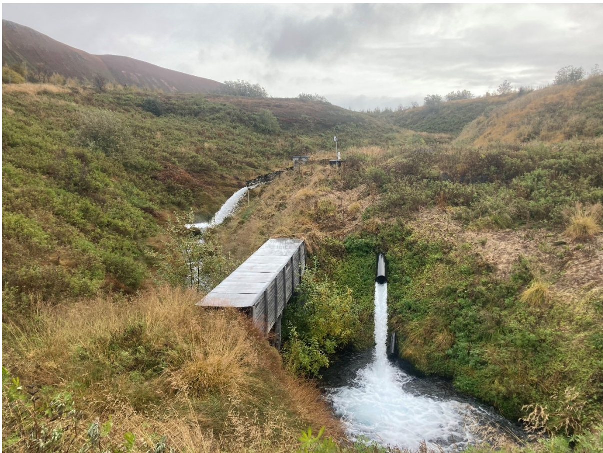
Mynd 5. Útrennsli um yfirfall á vatnstönkum í vatnsbólinu í Uppsprettagili.
