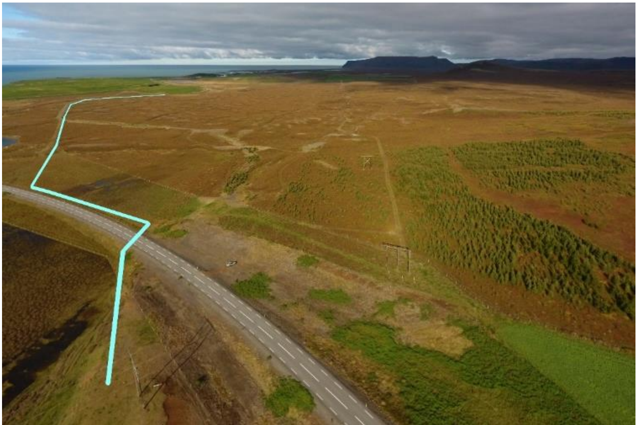
MYND 4 Horft til norðurs frá mastri 480. Strengleiðin þverar veginn skammt frá endamastri og fylgir slóð gegnum skógræktarsvæði norðan hans.
