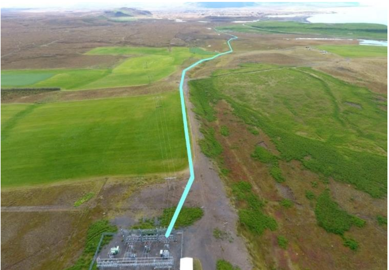
MYND 6 Horft til suðurs frá tengivirki á Kópaskeri. Strengleiðin liggur meðfram slóð við túnjaðar næst tengivirki, en fjær um gróna haga og mela.
