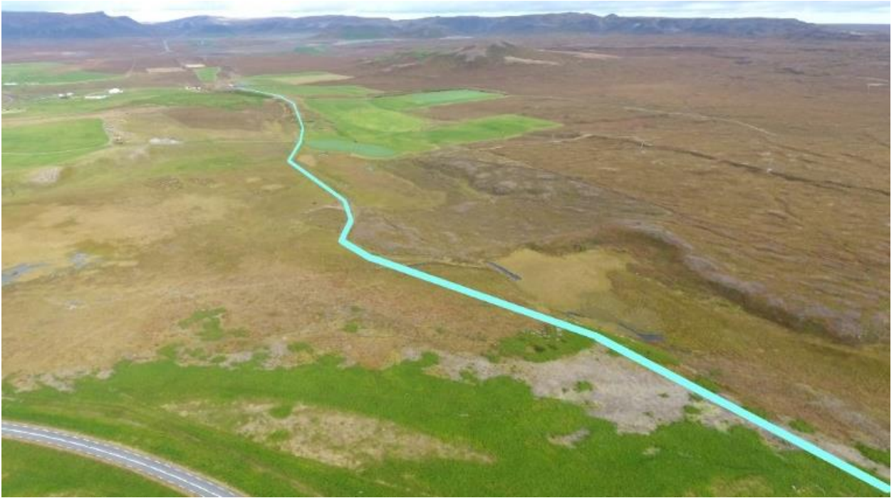
MYND 5 Horft til norðurs eftir strengleiðinni þar sem hún hefur skilið við slóðina og liggur meðfram núverandi lögnum vestan votlendis, sem liggur eftir sprungusvæði.
